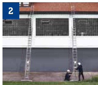
2 Verstärkte BAVARIA Leitern als Stützleitern aufstellen.
