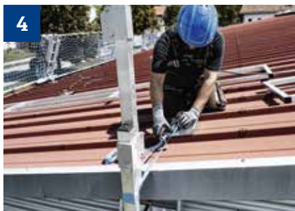
4 Pfosten mit Zurrgurt verankern.
