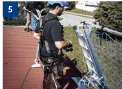
Geländer (und Netz) befestigen.
