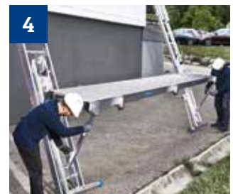
4 Arbeits-Plattform und Stütze auf dem Transport-Schlitten einhängen.
