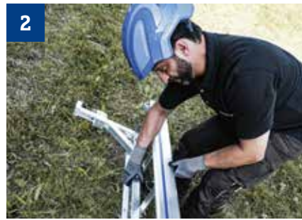
Geländerpfosten auf den Leitern befestigen.
