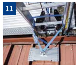
11 Stützleitern mit Zurrgurt verankern.
