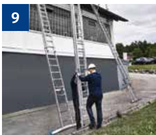
9 Zugangsleiter aufstellen.
