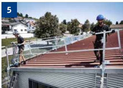
5 Geländer in Pfosten einhängen.
