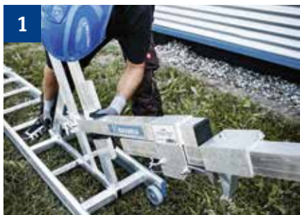
1 Geländerpfosten auf den Leitern befestigen.
