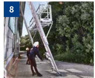
8 Schlitten und Bühne mittels Seilwinde nach oben kurbeln und in Arbeitsposition einrasten.
