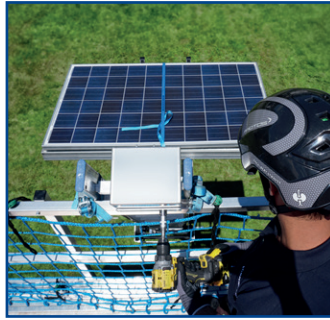
Solarmodule werden mit dem Leiterlift sicher transportiert.
